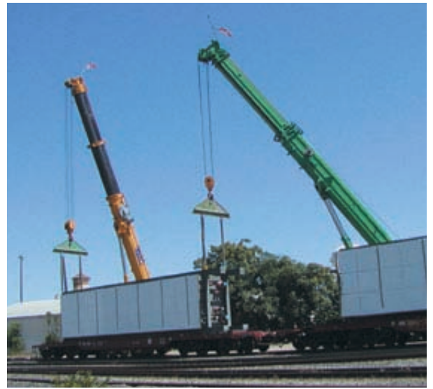
HRSG module load out for rail shipment to Canada
